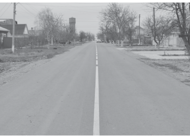
Новый асфальт по ул. Буденного
